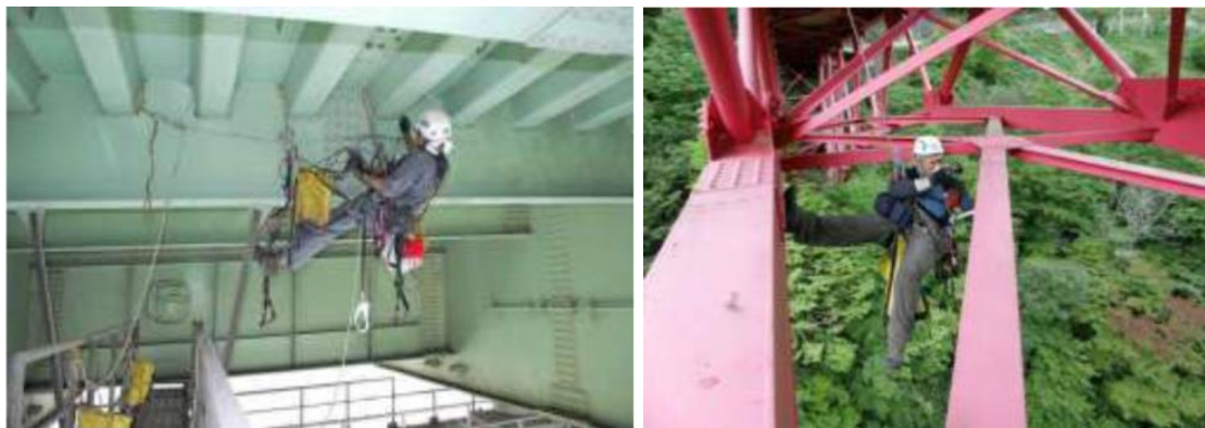
以人員吊掛方式進行橋梁檢測或修補
