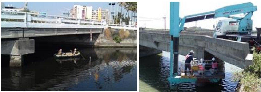
使用橡皮艇進入橋底或使用橋梁專用檢測車進行橋梁檢測
