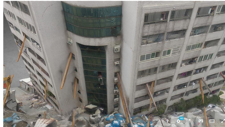
雲門翠堤大樓傾斜3D模型(水四月拍攝-20180212)
